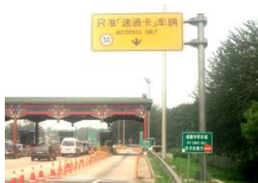
图 7-7 机场高速不停车收费车道
