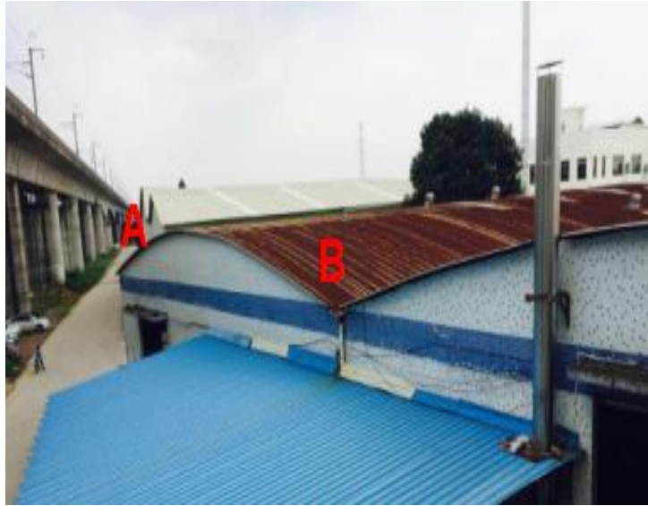
连拱式屋顶桁架式彩钢房照片
