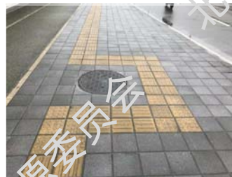
③ 盲道、路缘坡道与阻车桩平面布置示例
