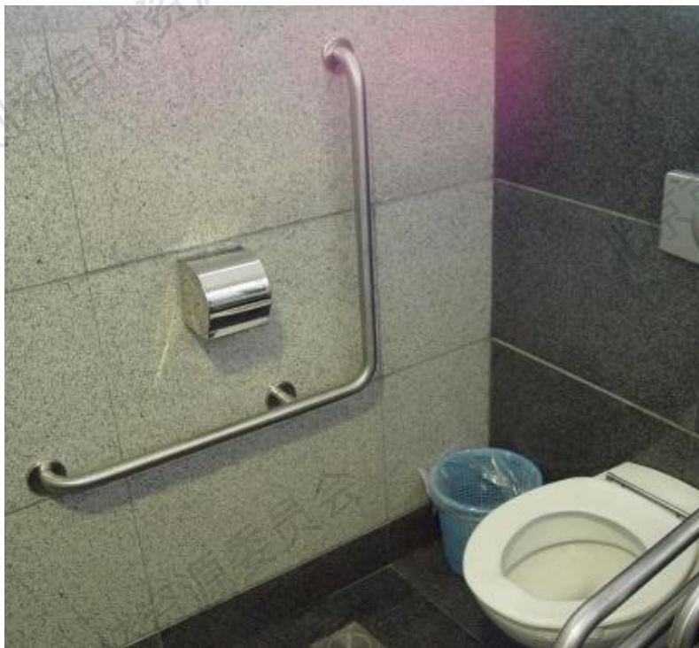
L型扶手安装方向有误，且位置尺寸不对
