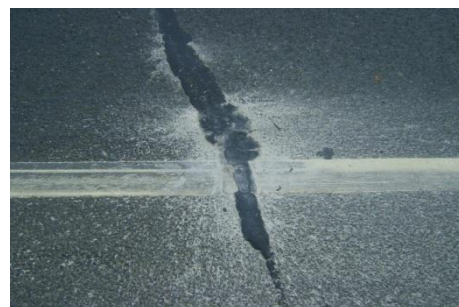
b) 横向裂缝位置唧浆
