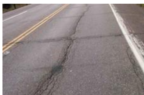
c) 重度纵向裂缝
