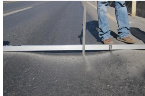
b) 横向裂缝位置唧浆
