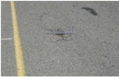
b) 轻度坑槽
