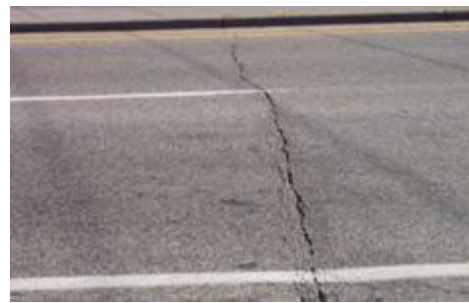
c) 重度横向裂缝
