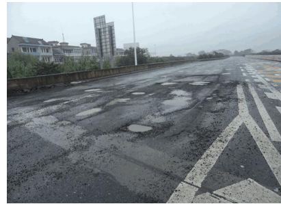
b) 重度沉陷病害
