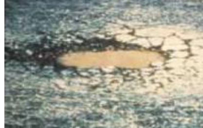
c) 重度坑槽
